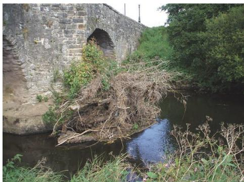
Embâcles problématiques au droit d'un pont qui augmentent le risque d'inondation à l'amont car ils constituent un obstacle à l'écoulement, d'érosion à l'aval en augmentant la vitesse des écoulements et de rupture de l'ouvrage en provoquant une pression plus forte sur l'ouvrage en cas de crue.
