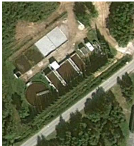
Vue aérienne de la station d'épuration du site
