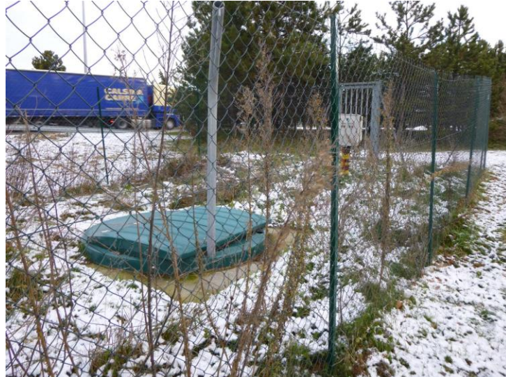
Vue du poste de relèvement
