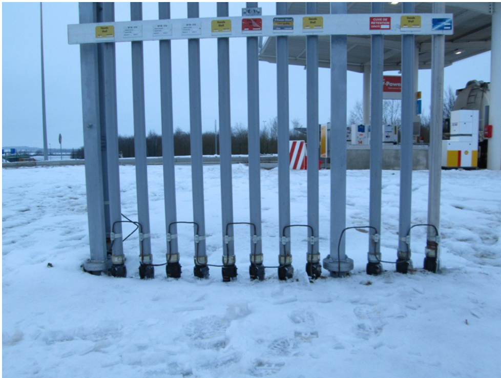
Illustration 7: Exemple équipotentiels tubes d'évents
