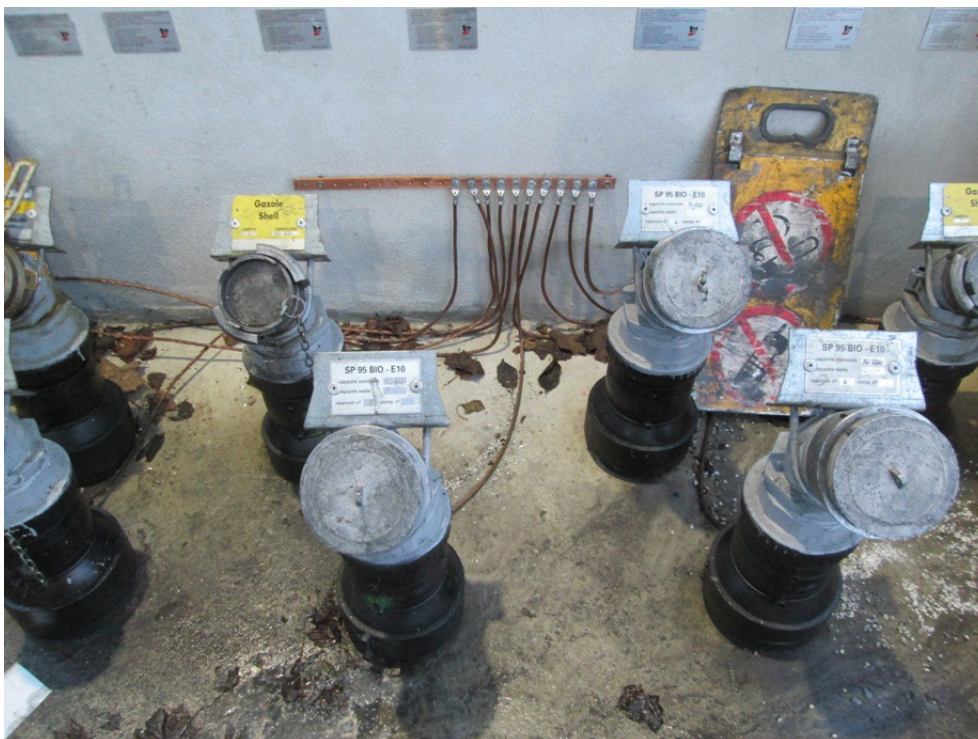
Illustration 8: Exemple équipotentiels tubes de dépotage
