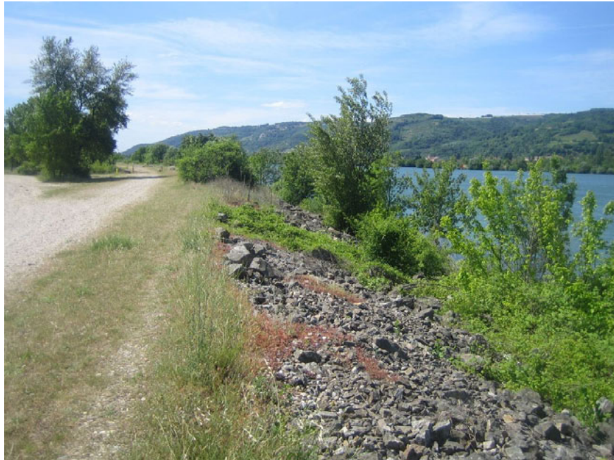
Berge du Rhône au Nord de l'agglomération de Saint-Vallier (Photo : DDT26)
