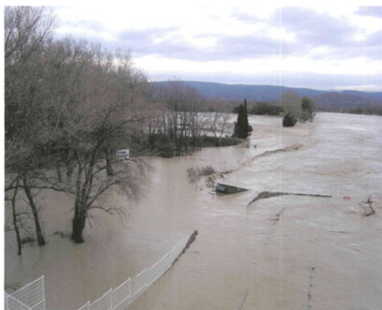
Décembre 2003 – aval barrage de Donzère (photo DDE)
