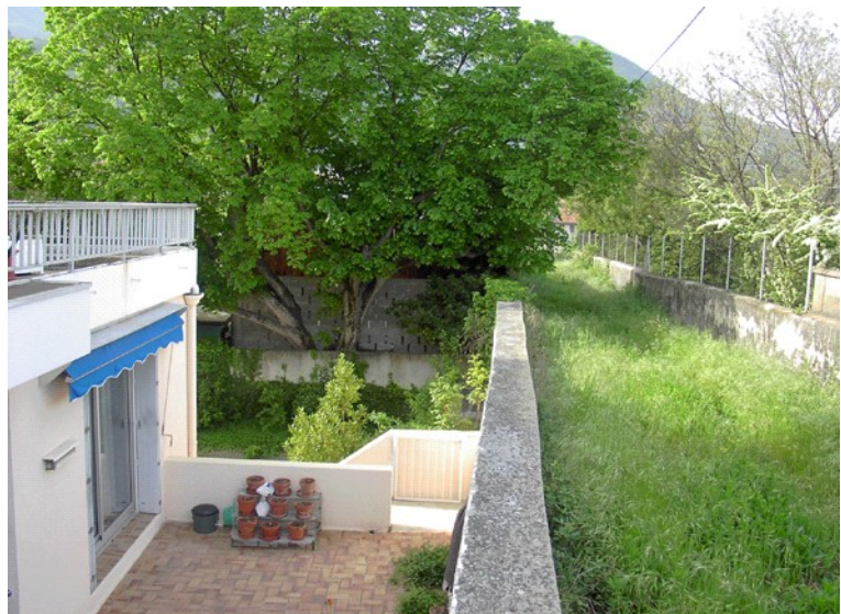
Cette photo du ravin d'Antignans montre la surélévation importante du lit de cet affluent par rapport au lit majeur de l'Eygues, liée à son endiguement.
