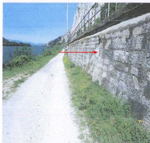
Emplacement repère n°1
