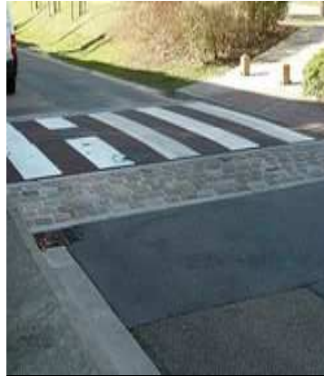
51- Traversée piétonne surélevée
