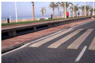
112- Espagne – surélévation de la traversée
