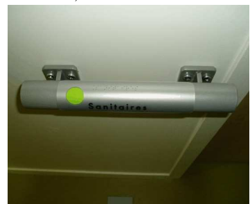
121- Information en braille sur barre de reprise d'appui, maison de l'autonomie, Grenoble
