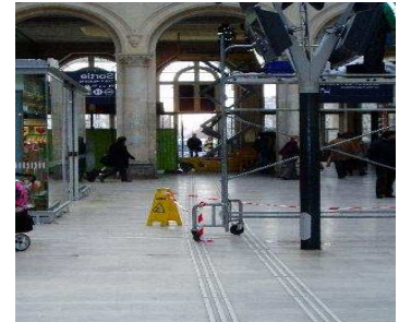
122- Échafaudage sur la bande
