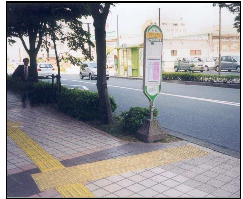
74- Simple rangée pour le guidage, double rangée vers l'arrêt TC, zone carrée terminale pour se différencier d'un passage piéton.
