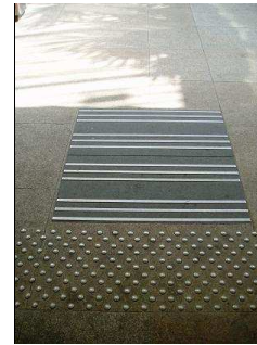
42- Métro la soie, Lyon, repérage de la zone d'ouverture des portes
