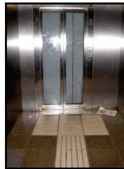
94- Barcelone – Dalles de grès striées de guidage avec positionnement dans le sens opposé au cheminement devant l'ascenseur.
