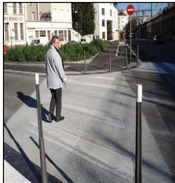
52- Revêtement granuleux appliqué en débord du passage piétons
