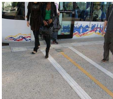
41- Tramway la Doua, Villeurbanne, repérage de la zone d'ouverture des portes
