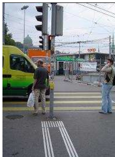
40- Passage piétons, Zurich, repérage du feu sonore
