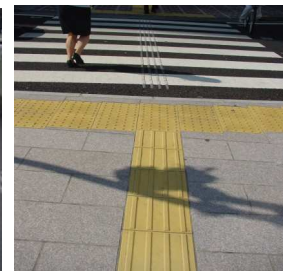
114- Japon – guidage de localisation sur trottoir et de repérage de traversée sur chaussée
