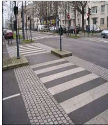
50- Deux bordures pavées encadrent la traversée
