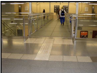
95- Barcelone – Dalles de grès striées opposées à l'axe de cheminement devant un plan incliné
