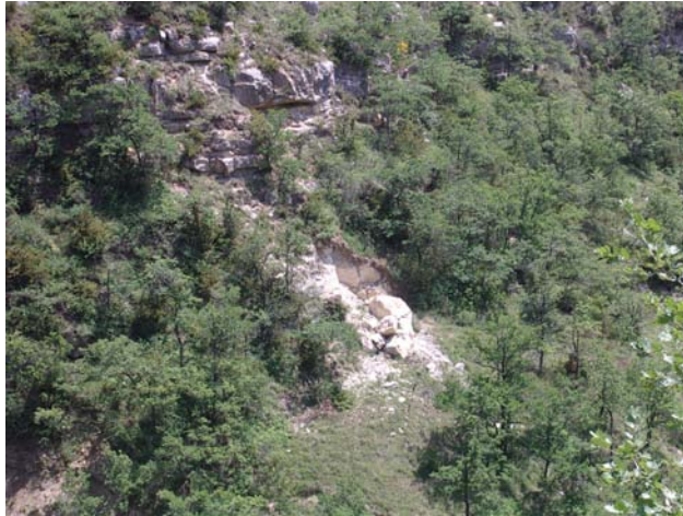
Eboulement de l'escarpement rocheux, en amont du village.
