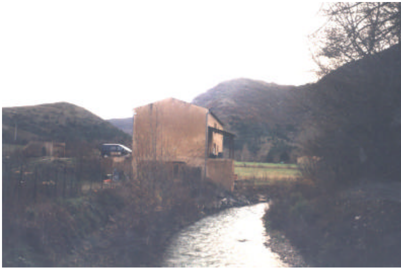
Maison en bordure rive droite de la rivière Méouge à l'amont du pont de la RD 546 (ancienne distillerie) Risque fort de crue torrentielle essentiellement du au problème d'érosion susceptible de survenir en crue
