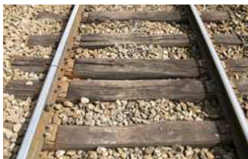
Rails courts sur traverses bois
