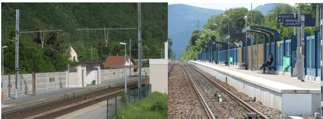
Exemples d'écrans acoustiques à Aiguebelle et Moirans
