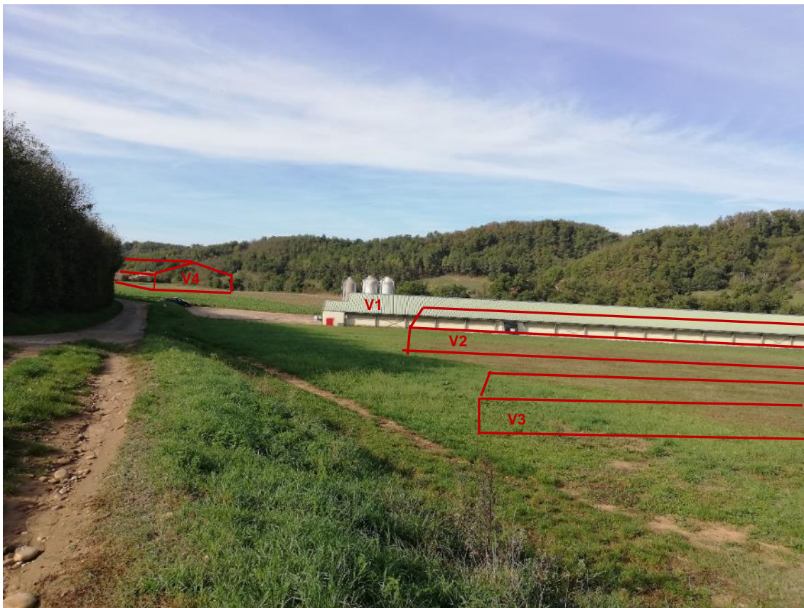
Figure 34 : Vue du site du projet depuis la voie communale passant devant le site et schéma des nouveaux bâtiments
