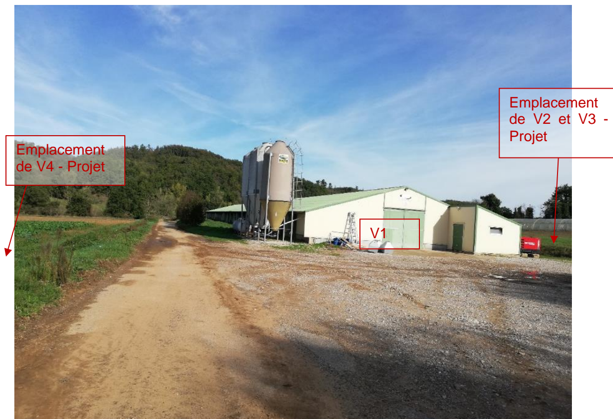
Figure 35 : Vue de l'emplacement des bâtiments depuis le Sud
