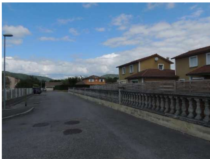
Figure 45 : Habitations sur le lotissement "Les Mirabelles" (HYD, 2019)
