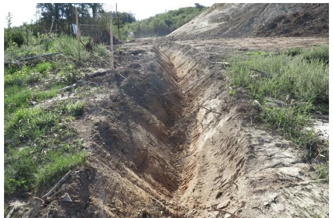
Exemple de fossés de récupération des eaux pluviales. ECOTER, 2016
