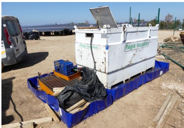
Tous les contenants de produits polluants doivent être placés sur des bacs de rétention ou sur une plateforme étanche adaptée - DRYOPTERIS, 2017
