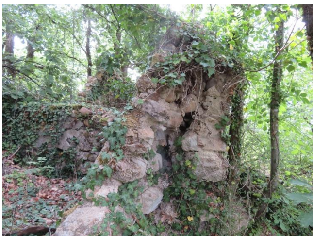
Vieille ruine présentant des fissures dans la maçonnerie
