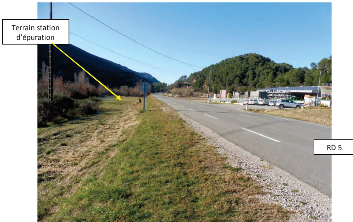
VUE SUR LE SITE DE LA STATION D'ÉPURATION DEPUIS LA RD5 Source : BET A. LÉGAUT
