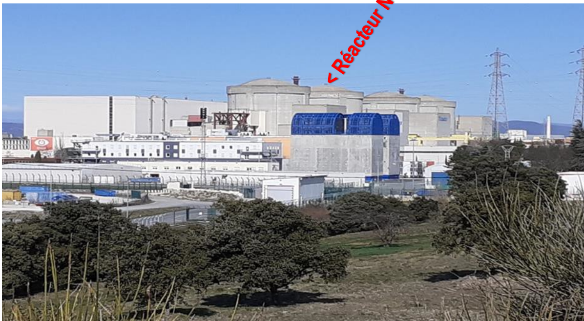
Vue générale de la centrale EDF de Tricastin
