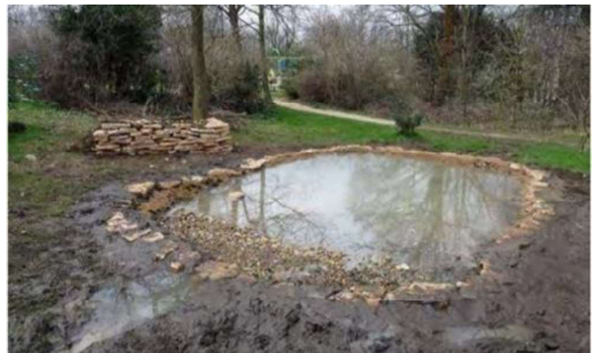
Mare avec berges en blocs de pierres et mur en pierre sèche Source : LPO Rhône et SMIRIL, 2013
