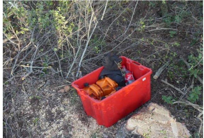
Stockage de produits polluants lors des travaux de bucheronnage DRYOPTERIS, 2017
