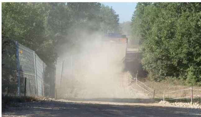
Exemple de levée de poussières lors du passage d'un camion : à éviter
