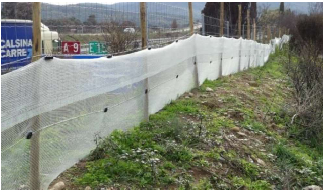
Exemple de clôture hermétique aux reptiles – DRYOPTERIS, 2016
