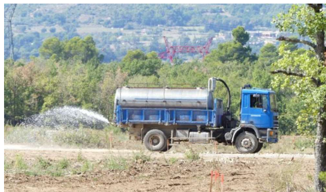
Humidification des pistes d'accès à l'aide d'un camion-citerne
