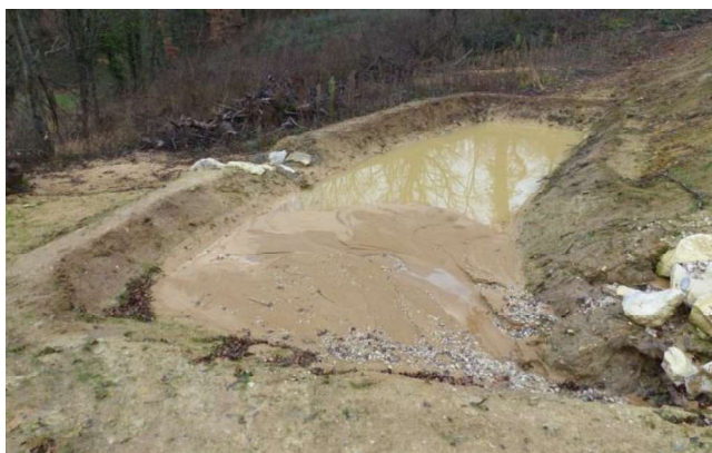
Bassin de rétention ayant permis la rétention d'une importante quantité de fines et nécessitant un curage – DRYOPTERIS 2017
