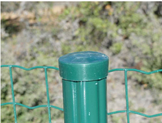
Exemples de clôture dont le sommet des poteaux a été obturé – DRYOPTERIS, 2017
