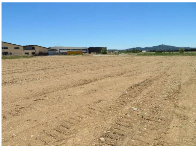
CV 20 : Zone récemment remblayée
