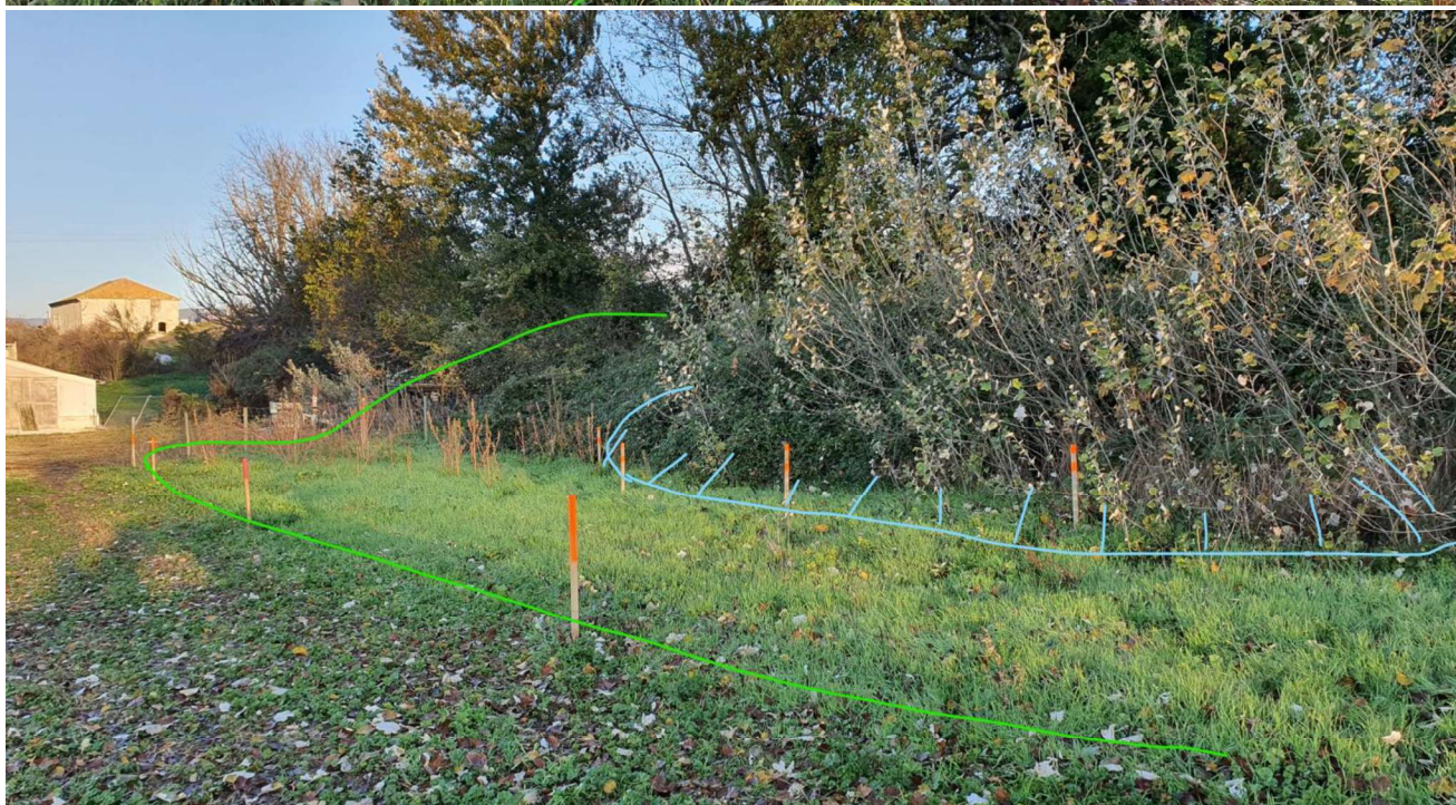
La délimitation de l'agrandissement de la mare se matérialise par la présence de piquets à 2 traits oranges ( couleur bleue ) et la clôture par la présence des piquets à un trait orange continu ( couleur verte ). – ECOTER, 2021.
