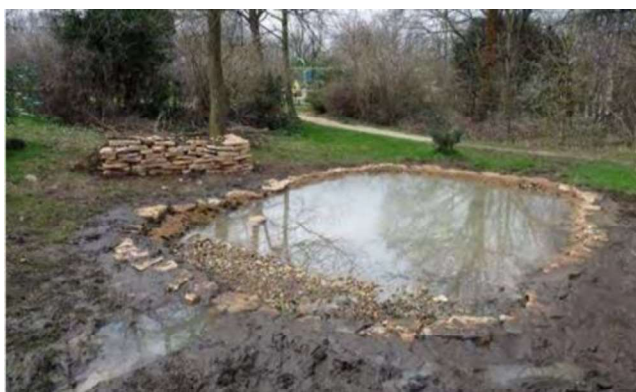
Mare avec berges en blocs de pierres et mur en pierre sèche Source : LPO Rhône et SMIRIL, 2013
