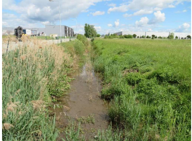
Fossé en eau
