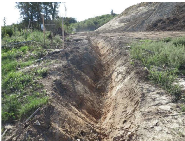
Exemple de fossés de récupération des eaux pluviales. ECOTER, 2016
