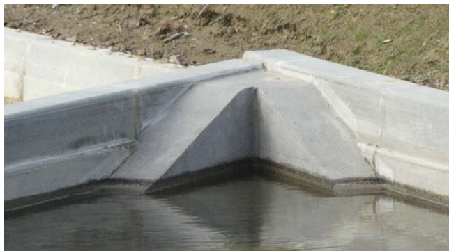
Exemples de rampes en béton permettant à la petite faune de franchir un trottoir. DRYOPTERIS, 2017.
