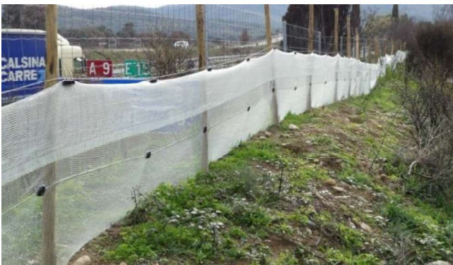
Exemple de clôture hermétique aux reptiles – DRYOPTERIS, 2016
