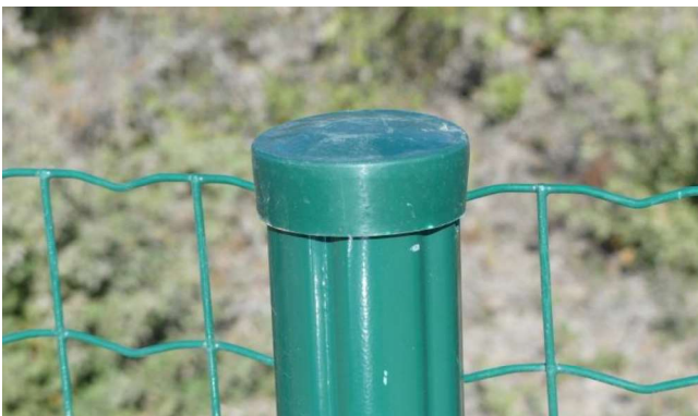
Exemples de clôture dont le sommet des poteaux a été obstrué – DRYOPTERIS, 2017
