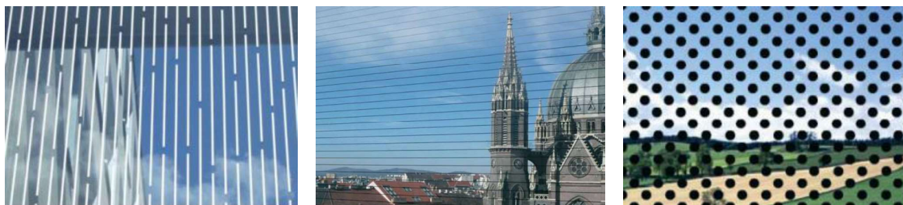
Exemples de marquages de vitres efficaces contre les collisions d'oiseaux (source : SCHMID et al , 2012)
