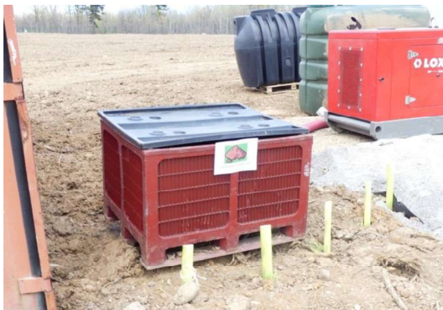
Stockage des terres et gravats pollués avant envoi vers un centre de traitement DRYOPTERIS, 2017
