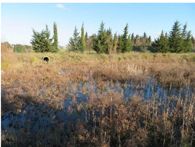
Bassin de rétention : zone inondée + végétation hygrophile dominante
