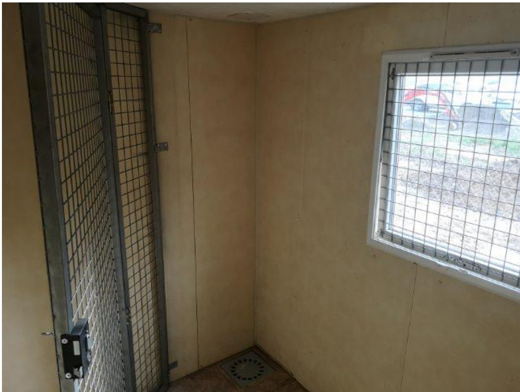
Pièce d'isolement, fenêtre et porte grillagées
