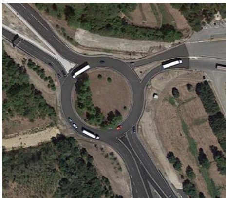
Vue aérienne du giratoire (Source : Google Maps)
