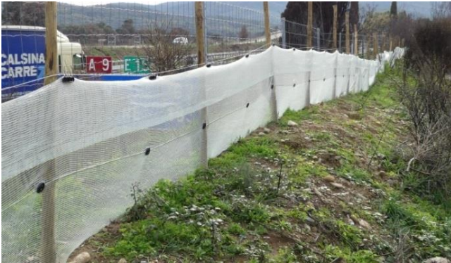
Exemple de clôture hermétique aux reptiles – DRYOPTERIS, 2016
