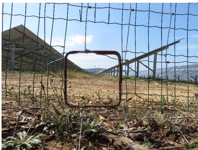
Trouées renforcées créées sur une clôture – DRYOPTERIS, 2018
