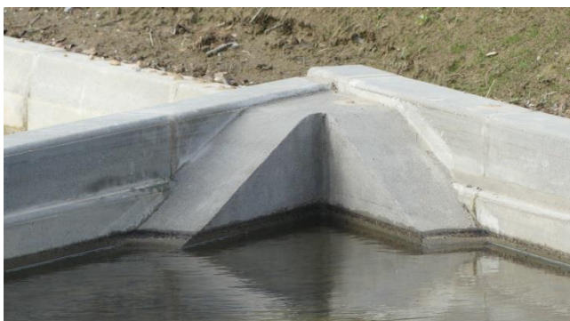
Exemples de rampes en béton permettant à la petite faune de franchir un trottoir. DRYOPTERIS, 2017.
