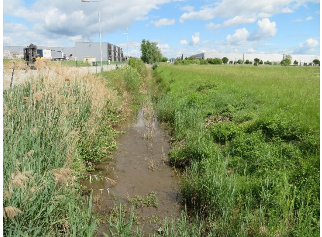
Fossé en eau
