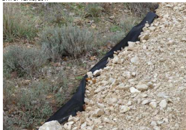
Géotextile placé sous une surface empierrée temporairement DRYOPTERIS, 2017
