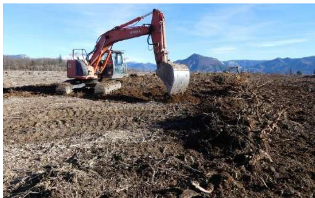
Retrait des souches par peignage superficiel du sol à l'aide de pelles mécaniques équipées de godets à dents. Puis andainage des souches extraites avant le broyage. Source : DRYOPTERIS, 2016
