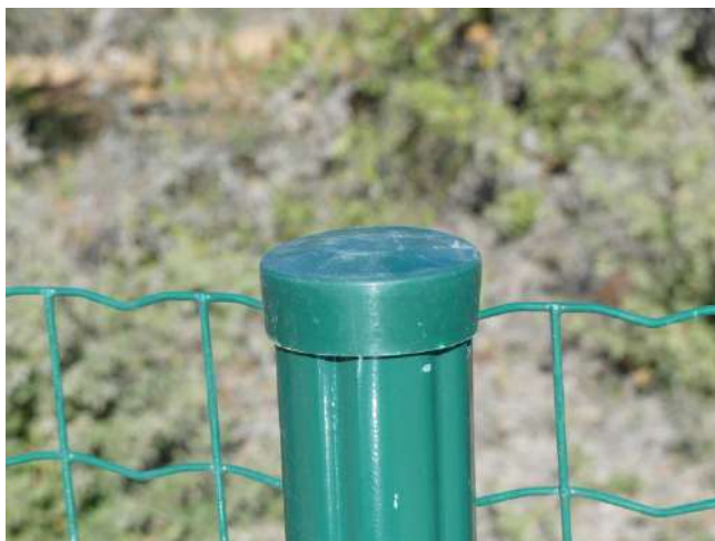
Exemples de clôture dont le sommet des poteaux a été obstrué – DRYOPTERIS, 2017
