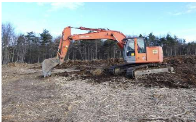
Retrait des souches par peignage superficiel du sol à l'aide de pelles mécaniques équipées de godets à dents. Puis andainage des souches extraites avant le broyage. Source : DRYOPTERIS, 2016
