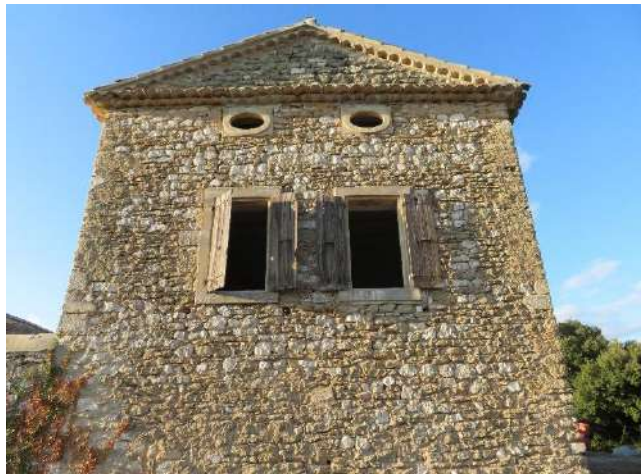
Vieux corps de ferme en restauration favorable à l'accueil de chauves-souris
