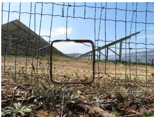
Trouées renforcées créées sur la clôture d'un parc photovoltaïque – DRYOPTERIS, 2018
