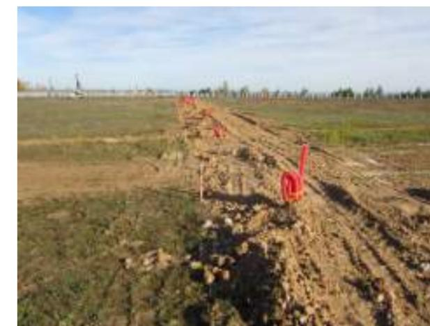
Exemple de tranchée et pose de câbles dans des fourreaux
