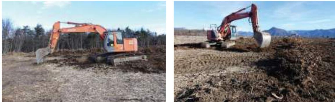
Retrait des souches par peignage superficiel du sol à l'aide de pelles mécaniques équipées de godets à dents. Puis andainage des souches extraites avant le broyage.
