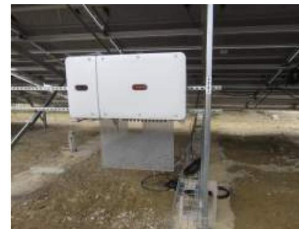
Exemple d'onduleur décentralisé
