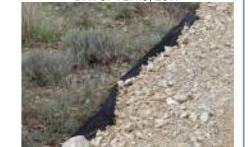
Géotextile placé sous une surface empiercée temporairement
