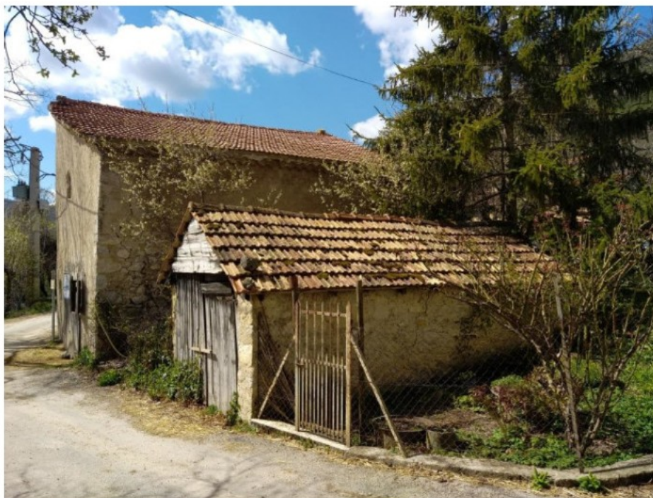
Vue de la bâtisse à rénover depuis l'aval du site
