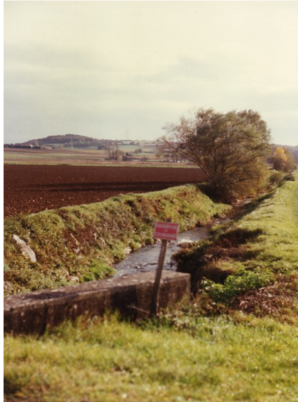
Figure 64 : La Veune suite au remembrement, aval du lavoir de Veunes
