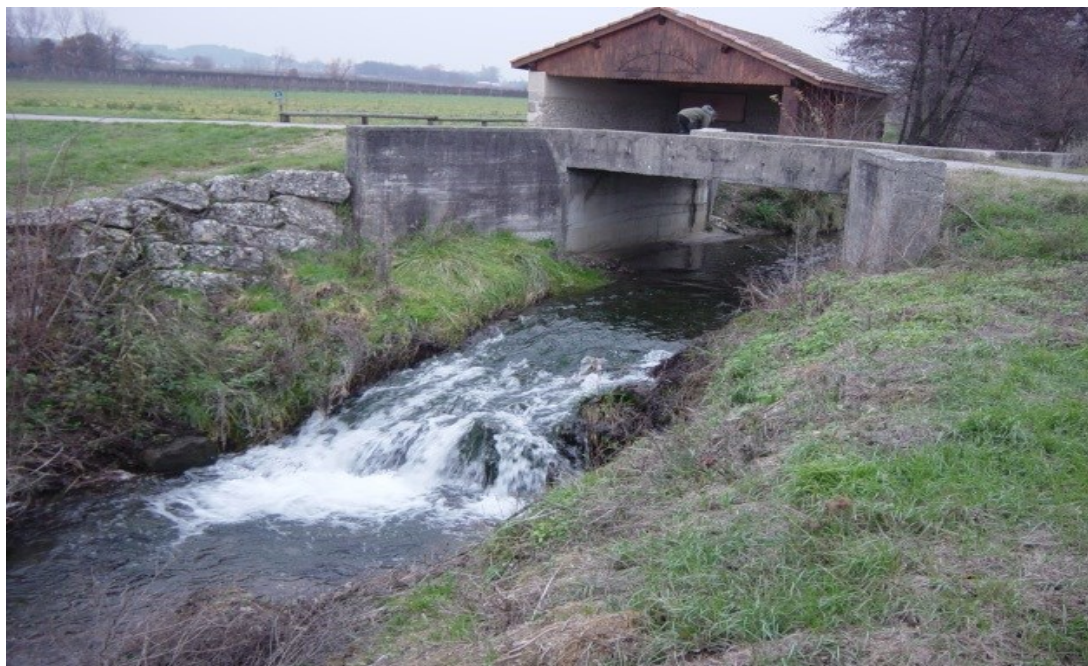
Figure 70 : Incision du lit > Chute de 1.7 m au lavoir de Veunes
