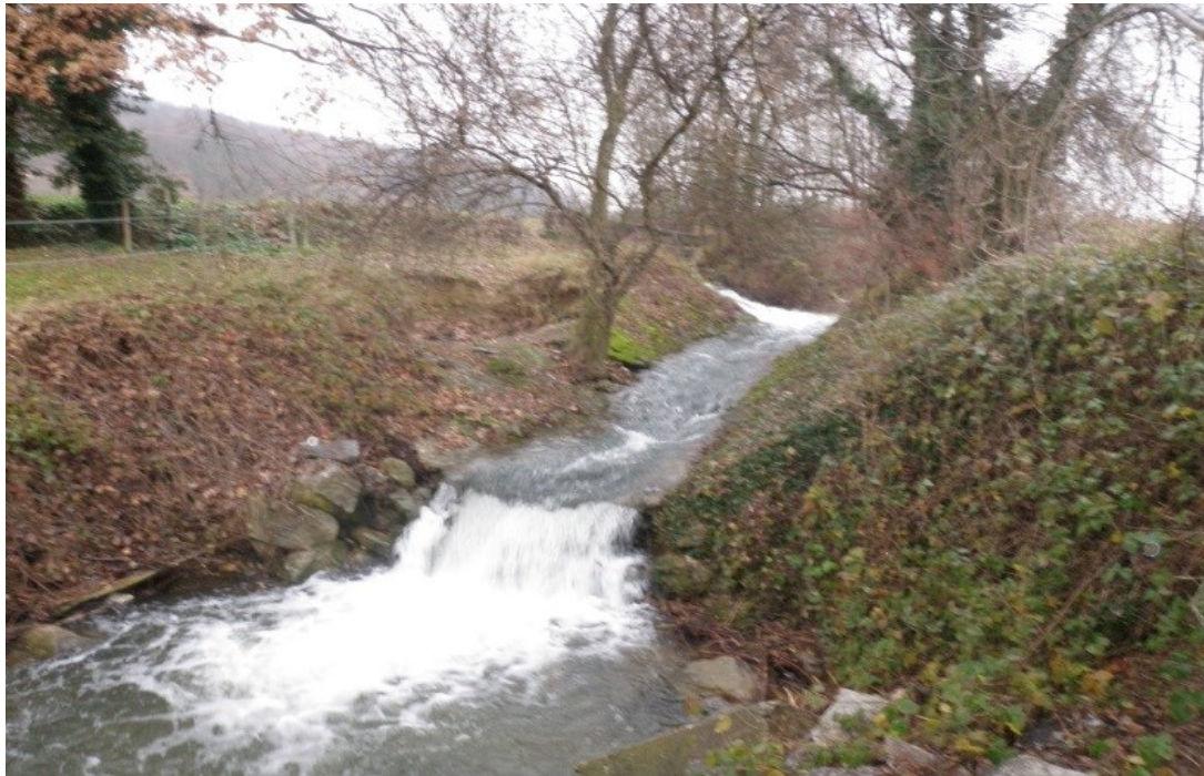
Figure 69 : Enfoncement du lit > incision > chute de 1.2 m à la prise d'eau du canal de Curson
