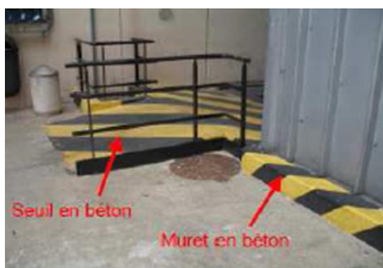
Seuil / muret béton
