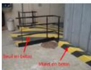
Seuil / muret béton
