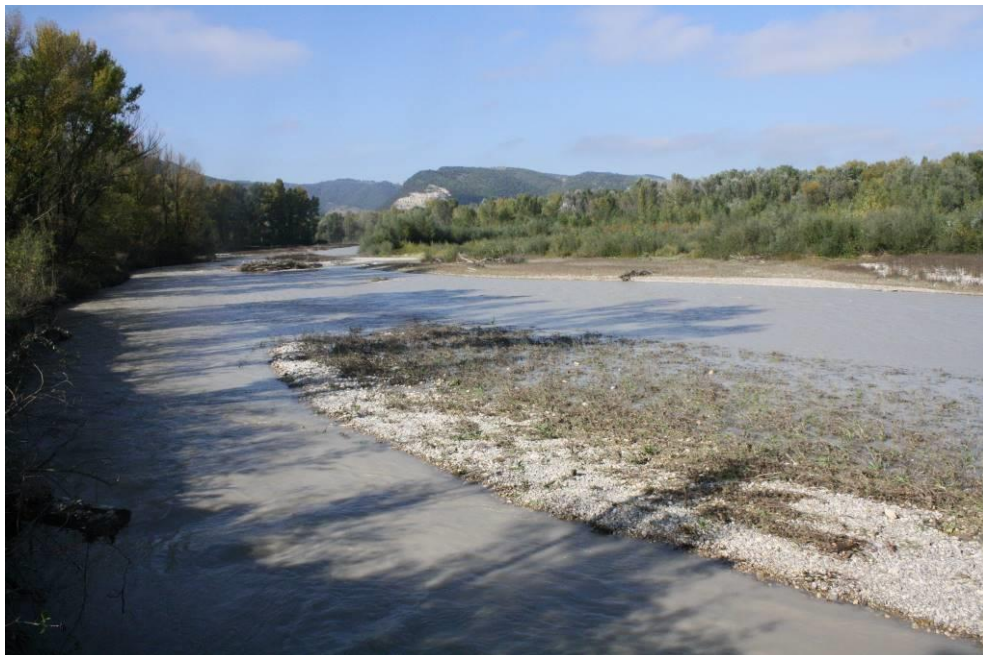
Figure 40. Vue du piège à graviers de la Drôme depuis l'amont rive gauche (ACME, 2013)
