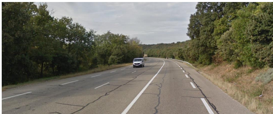
Absence d'aménagement cyclable et/ou piéton le long de la RN7
