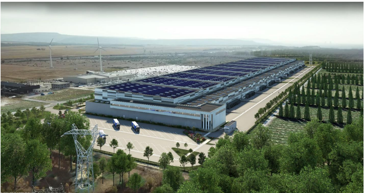
Insertion paysagère en vue aérienne depuis le Nord-Ouest
