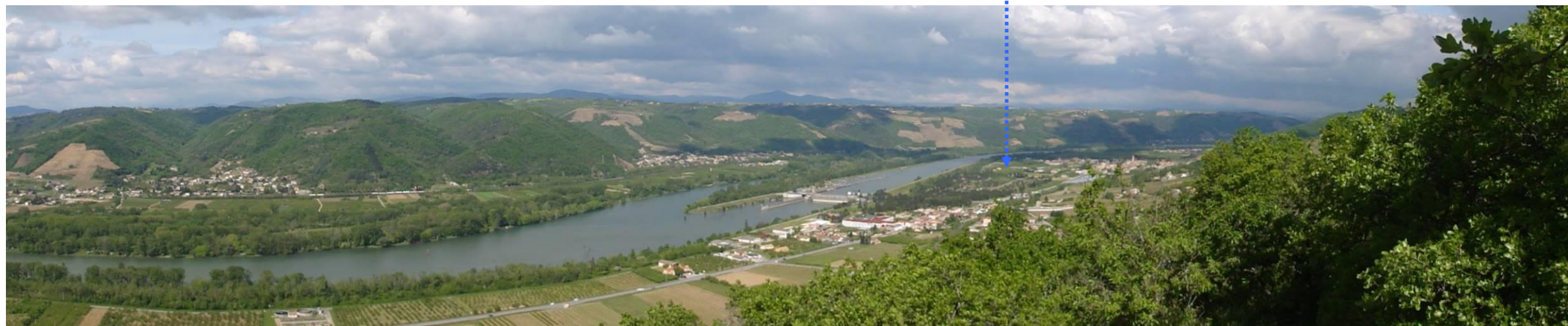
Pdv 1 : Depuis le belvédère de Méjans, le vaste panorama permet de visionner le site d'étude en contrebas dans la vallée. Enjeu de visibilité
