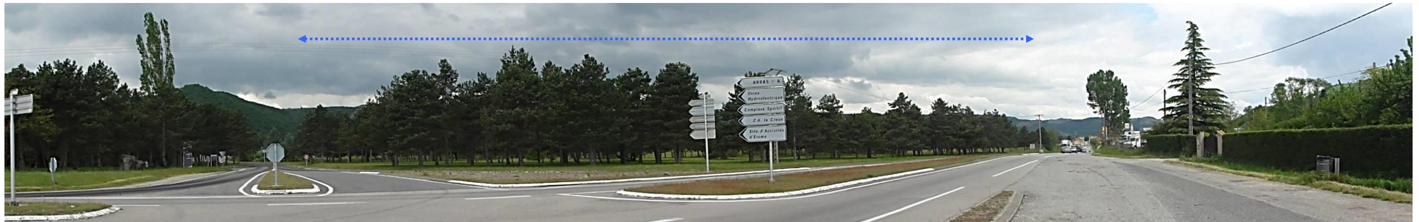
Pdv 14 : Depuis la RN7 à la limite sud-est du secteur d'étude. Le secteur d'étude borde la RN7. Enjeu de visibilité.
