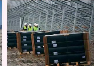
Montage des modules photovoltaïques sur les structures
