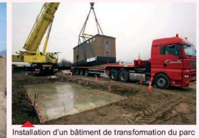
Installation d'un bâtiment de transformation du parc
