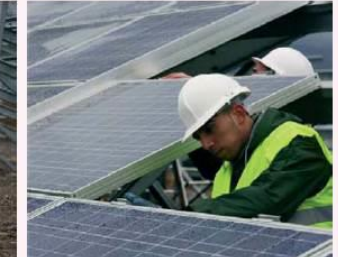
Montage des modules photovoltaïques sur les structures
