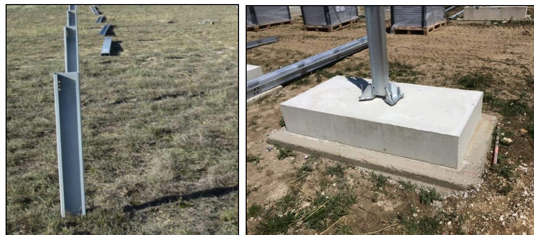
Photographie 36 : Pieux battus (à gauche) et plot béton (à droite)
