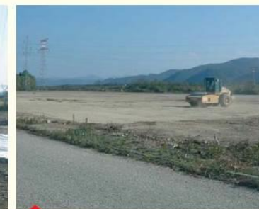
Nivellement et stabilisation de la plate-forme du parc
