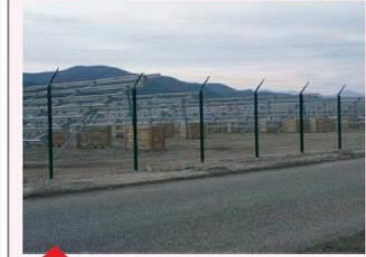
Clôture périphérique du site
