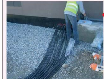
Arrivée des boîtes de jonction à l'un des 4 postes de transformation
