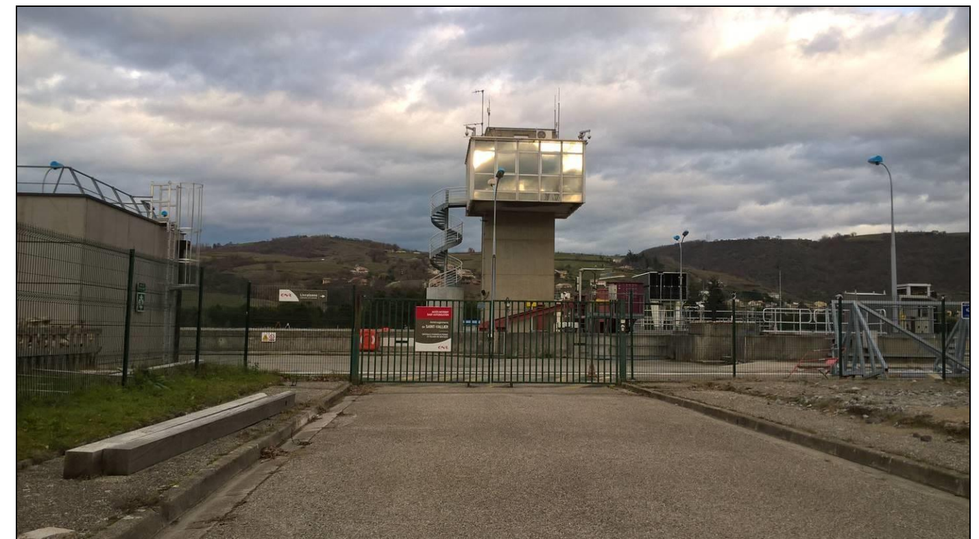
Photographie 9 : Centrale hydroélectrique de Gervans
