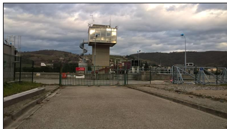
Photographie 1 : Usine hydroélectrique de Gervans à proximité directe du secteur d'étude
