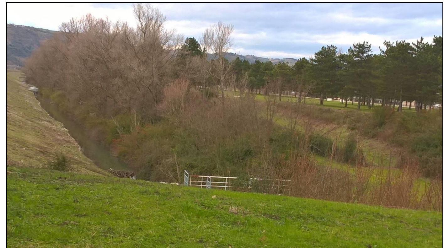
Photographie 31 : Limite ouest du secteur d'étude au niveau du contre canal en amont de la centrale hydroélectrique
