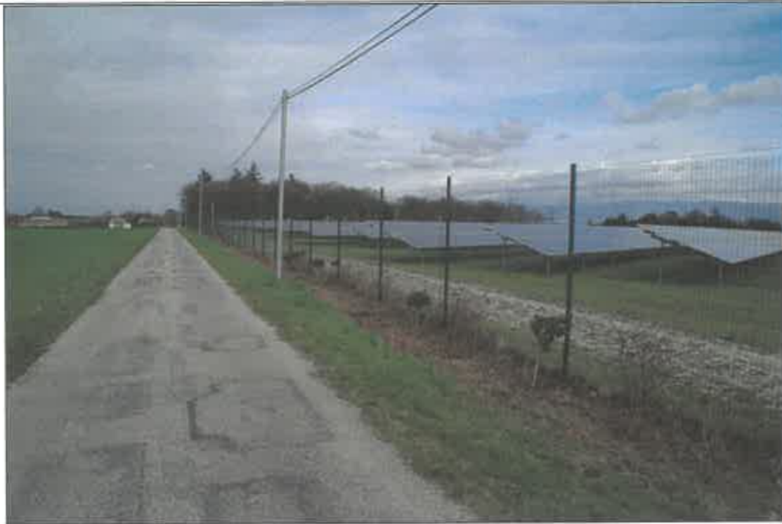
Limite Ouest du parc existant, avant application de la mesure MA1 Source : Artifex
