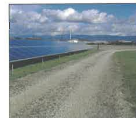
Piste de circulation en concassé Source : ARTIFEX
