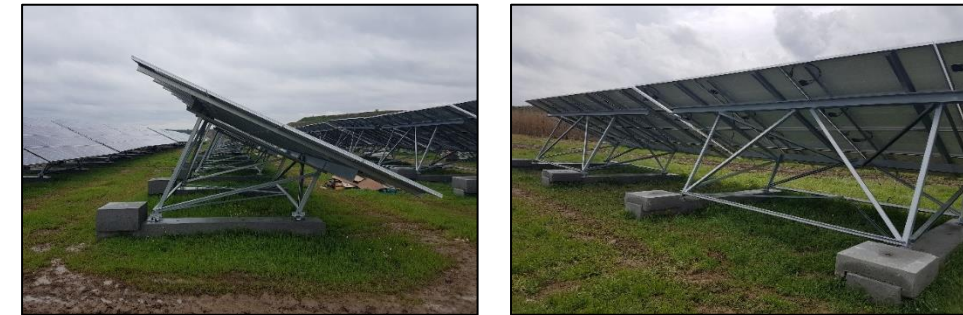
Exemple de fondations béton Source : RES
