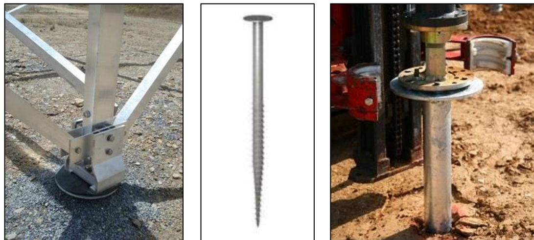
Fondations à visser Source : RES
