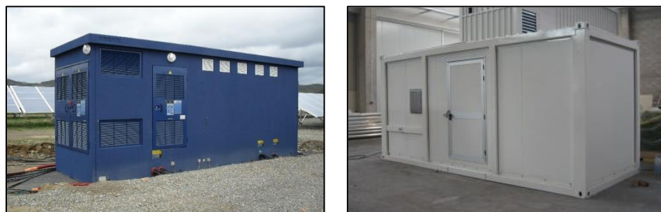
Exemples d'onduleurs et transformateur installés dans des postes béton et containers Source : RES
