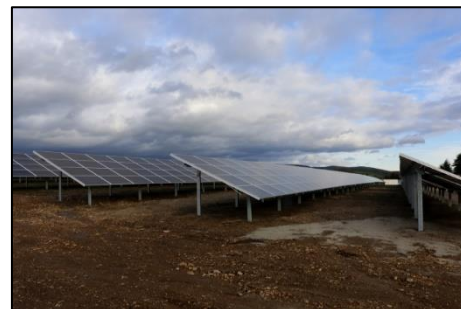
Exemple d'espace non empierré entre tables Source : RES
