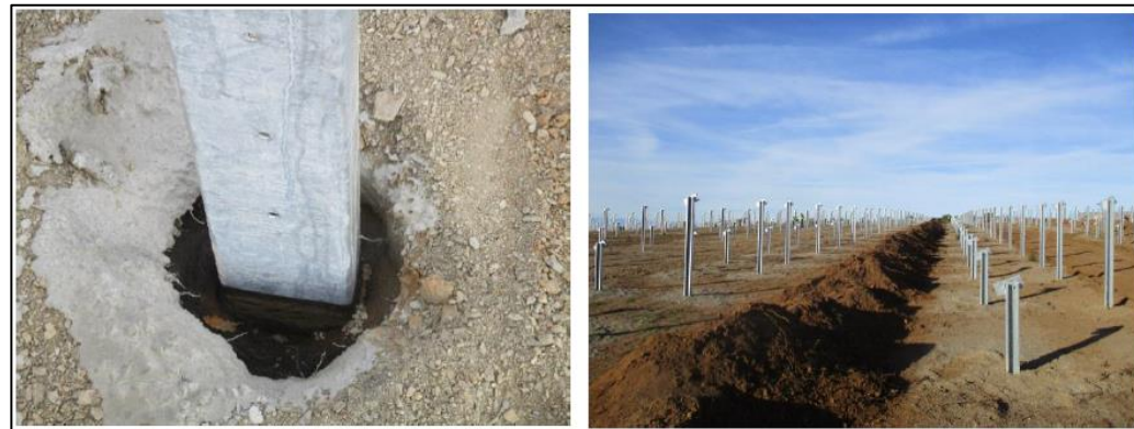
Exemple de fondation type pieux Source : RES
