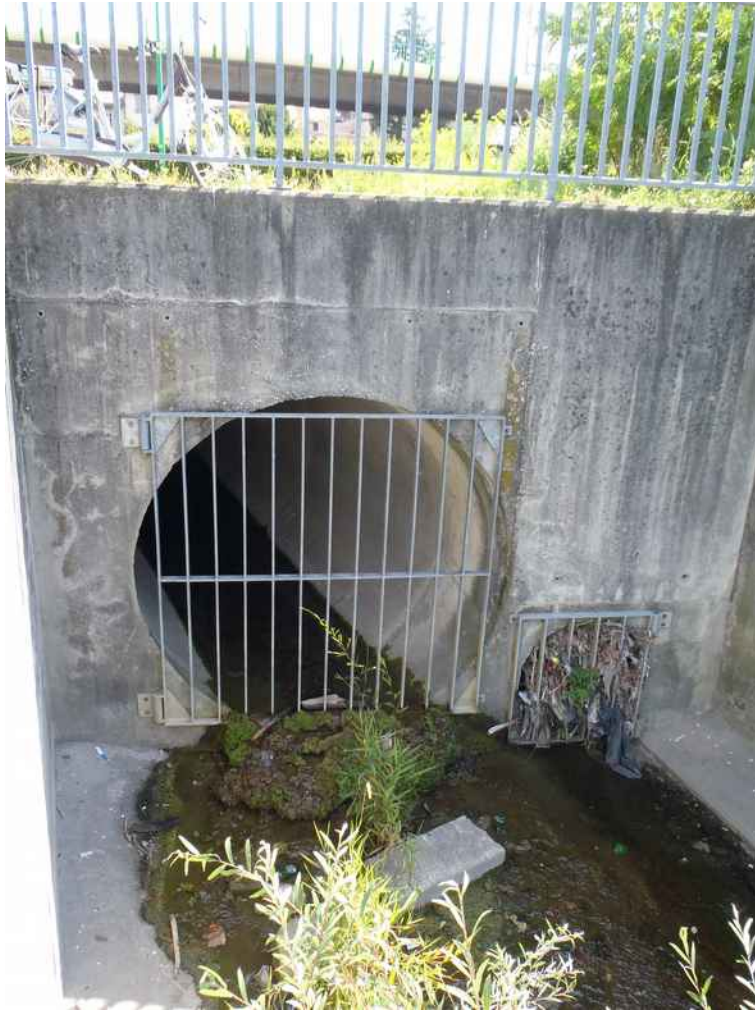
Exutoire de la Barberolle au niveau du bassin de joutes (photo DDT26)
