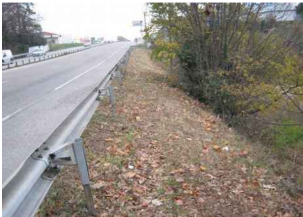
L'avenue de Romans et le parement amont du bassin des Couleures (photo SIABB/SAFEGE)
