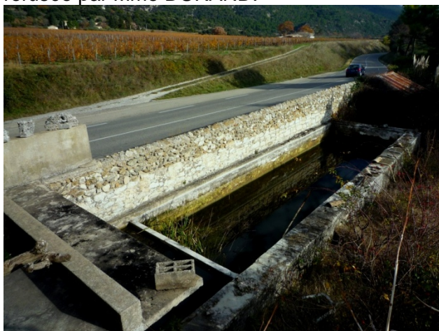
Figure 8 : Le mur de séparation et le bassin AO150
