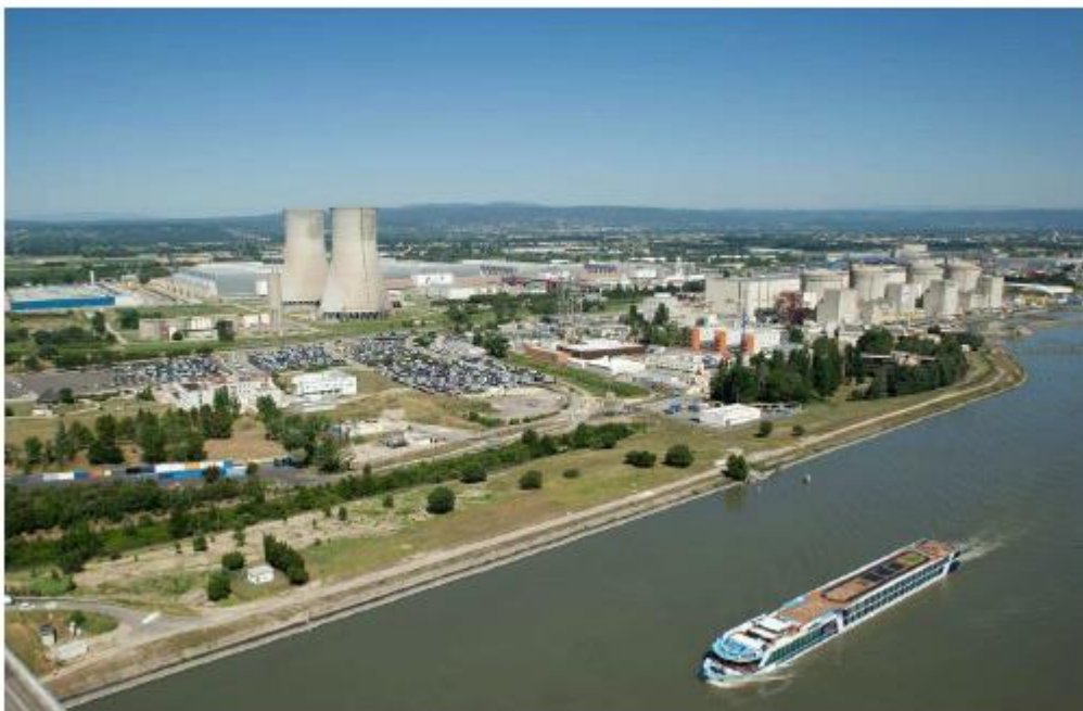
Figure 2 : Vue générale du site du Tricastin. Source : dossier.
