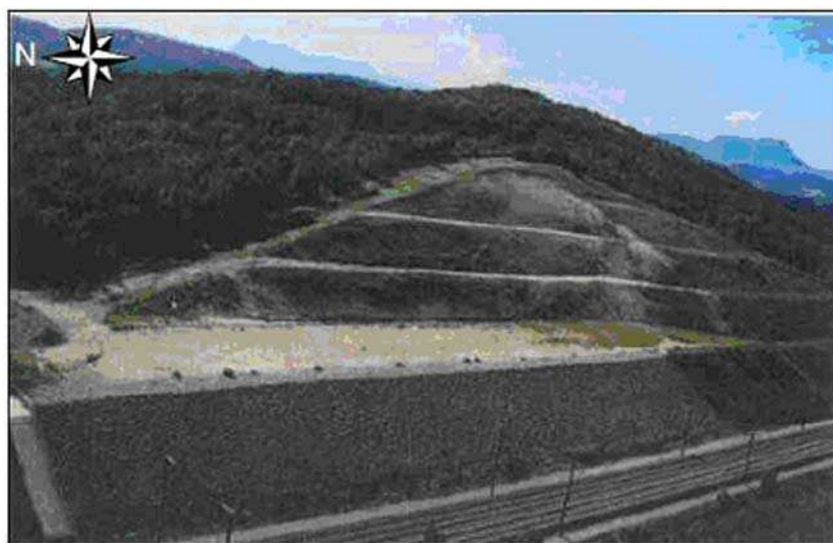
Le talus, vu depuis l'autre côté de la voie ferrée. La végétation permet de distinguer nettement le volume (45 000 m 3 ) déchargé en 2004. Source étude d'impact
