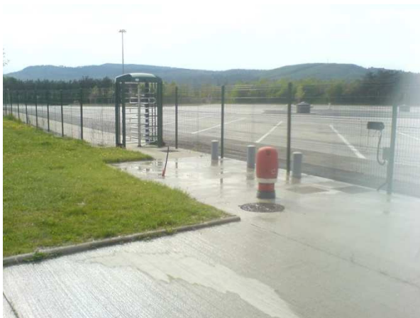
Poteau incendie aire est- à l'arrière station service PL
